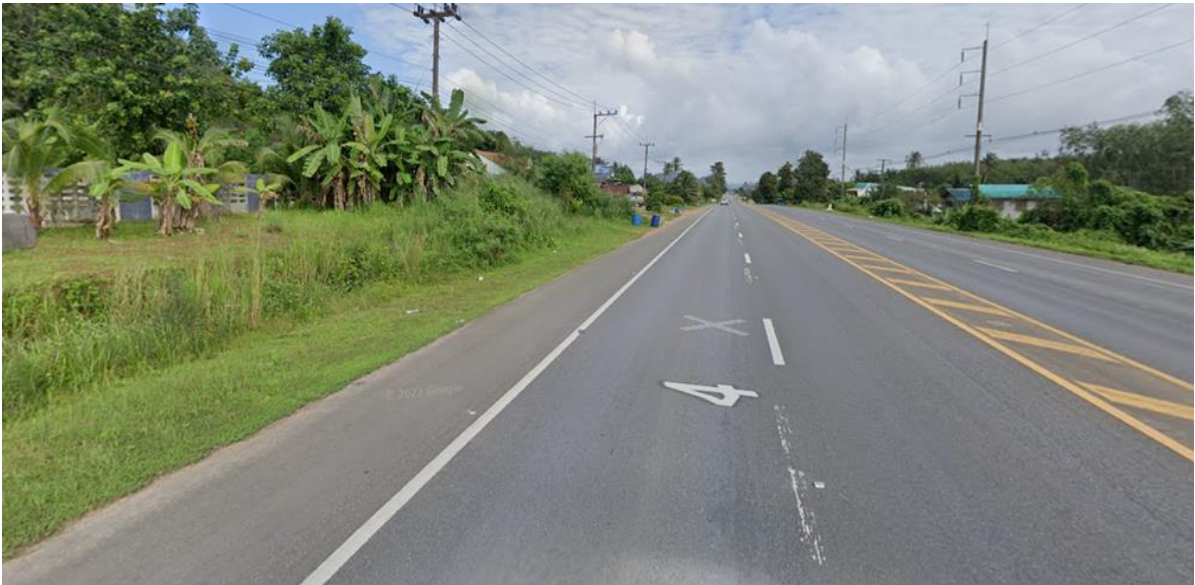
รูปที่ 4.4-1 ทางหลวงแผ่นดินหมายเลข 4 กม.956+105 จังหวัดกระบี่ ทิศทางขาเข้า
