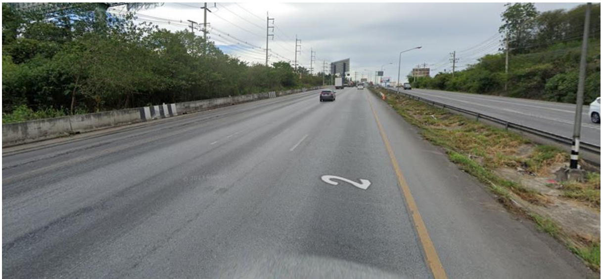
รูปที่ 3.5-2 ทางหลวงแผ่นดินหมายเลข 2 กม.54+050 จังหวัดนครราชสีมา ทิศทางขาออก (ทางลาดขึ้น)
