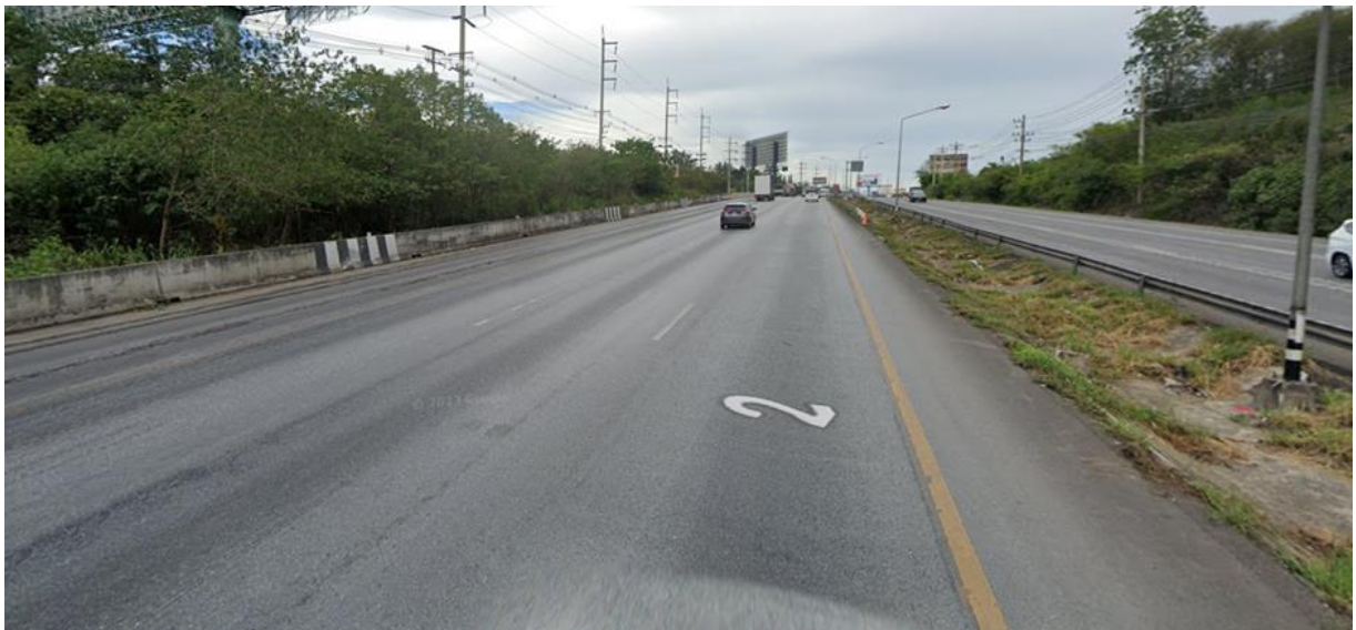
รูปที่ 4.5-2 ทางหลวงแผ่นดินหมายเลข 2 กม.54+050 จังหวัดนครราชสีมา ทิศทางขาออก (ทางลาดขึ้น)
