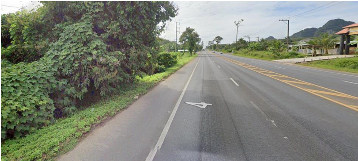
รูปที่ 3.4-2 ทางหลวงแผ่นดินหมายเลข 4 กม.956+105 จังหวัดกระบี่ ทิศทางขาออก
