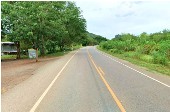
ทางหลวง 2 ช่องจราจรที่จำกัดการแซง 1 ทิศทาง
