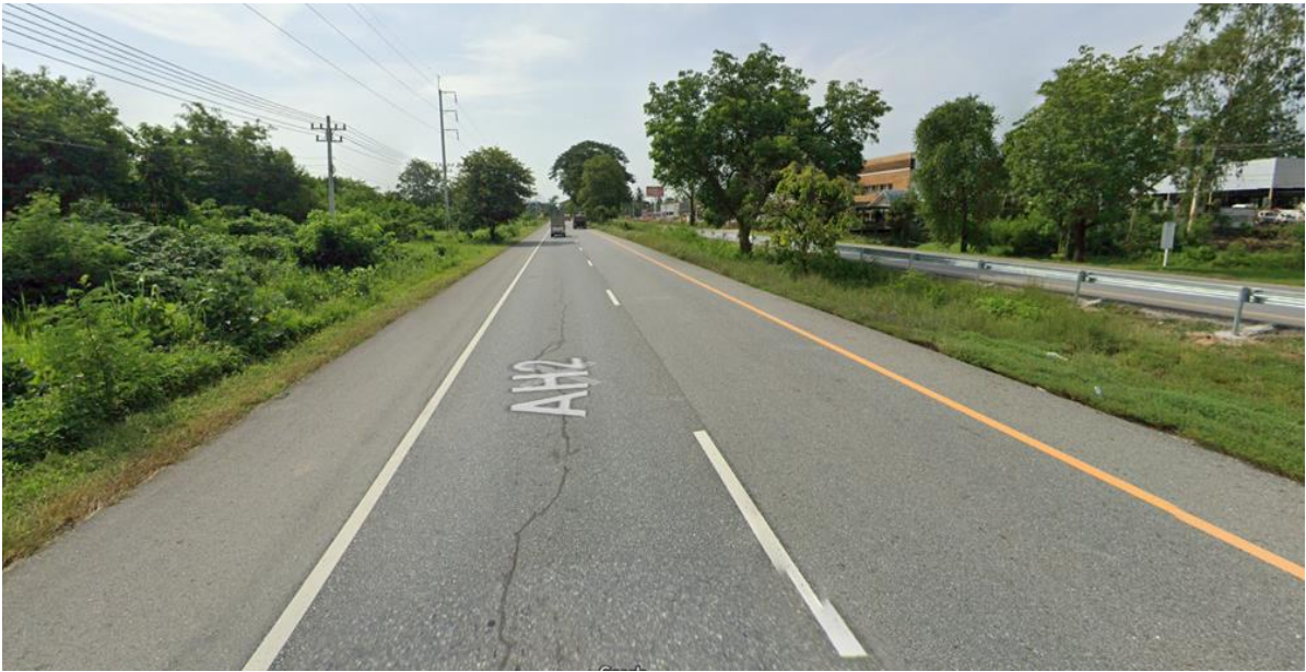
รูปที่ 4.2-1 ทางหลวงแผ่นดินหมายเลข 1 กม.511+591 จังหวัดตาก ทิศทางขาเข้า
