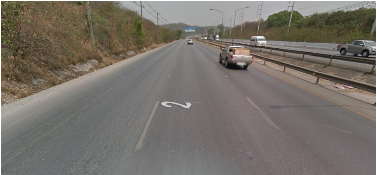
รูปที่ 4.5-1 ทางหลวงแผ่นดินหมายเลข 2 กม.54+050 จังหวัดนครราชสีมา ทิศทางขาเข้า (ทางลาดลง)
